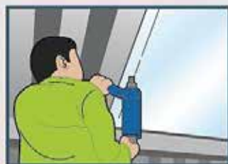
ใช้สว่านไฟฟ้า และตะปูเกลียวขนาดเบอร์ 10 ยาว 5/8 นิ้ว ชนิดเจาะเหล็ก ทบ 2.3 - 3.2 มม. หรือ ตะนากาว ยึด Roof Batt ให้อยู่กับจันทันในทุกระยะ 30 ซม.
