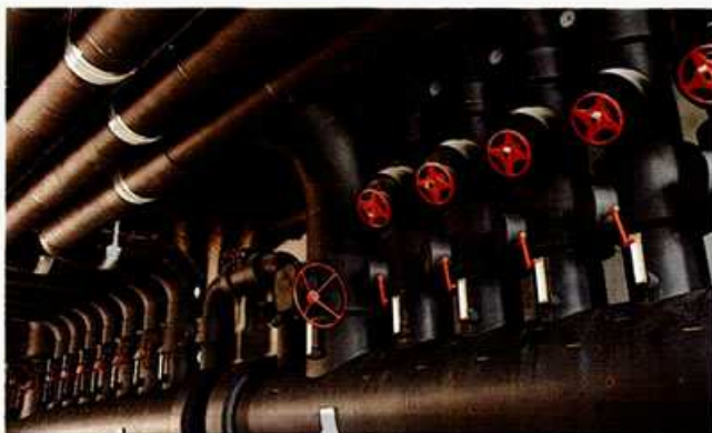
แอร์โรเฟล็กซ์มีคุณสมบัติบีบอัดได้เอง มีความยืดหยุ่นสูงและง่ายต่อการติดตั้ง ฉนวนแอร์โรเฟล็กซ์จึงเป็นฉนวนที่เหมาะสมกับอาคารต่างๆ เนื่องจากความปลอดภัยและช่วยป้องกันปัญหาหยดน้ำของท่อน้ำเย็น
